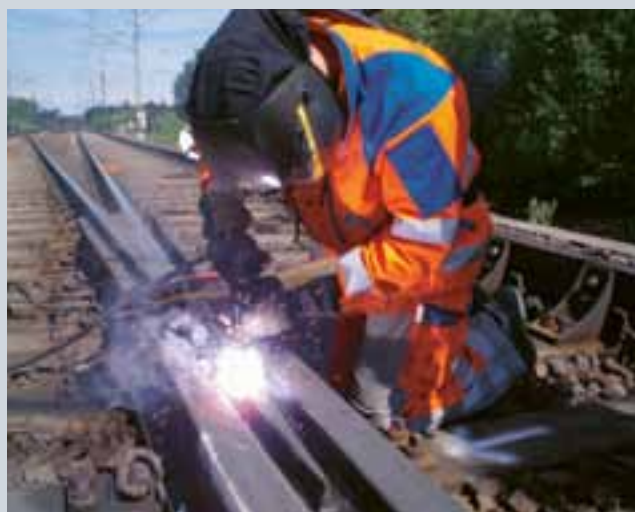
Påsvetsning i en spårväxel (Foto Infranord).
