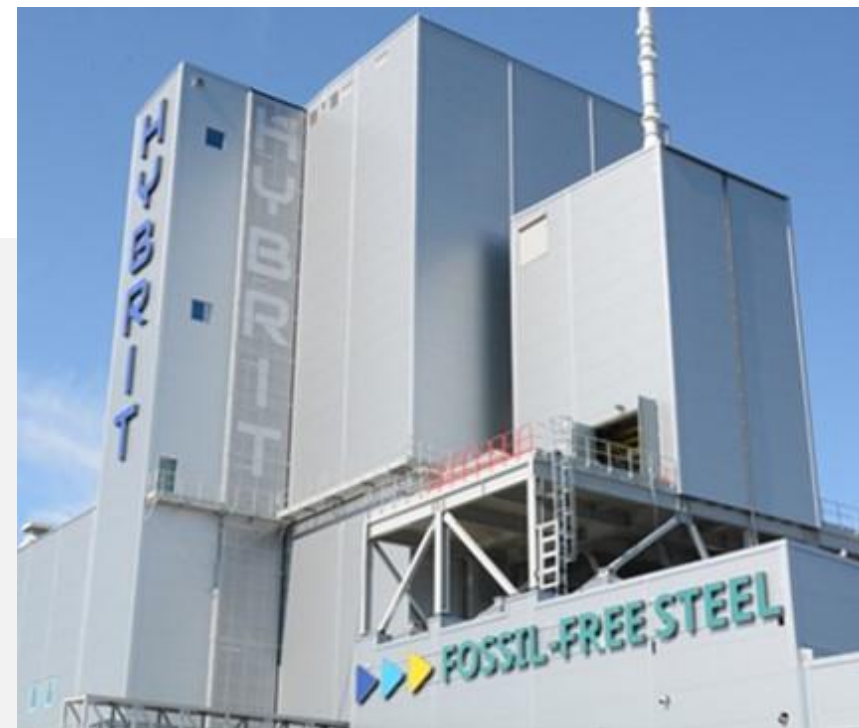
Hybrits pilotanläggning, vätgasbaserad reduktion
